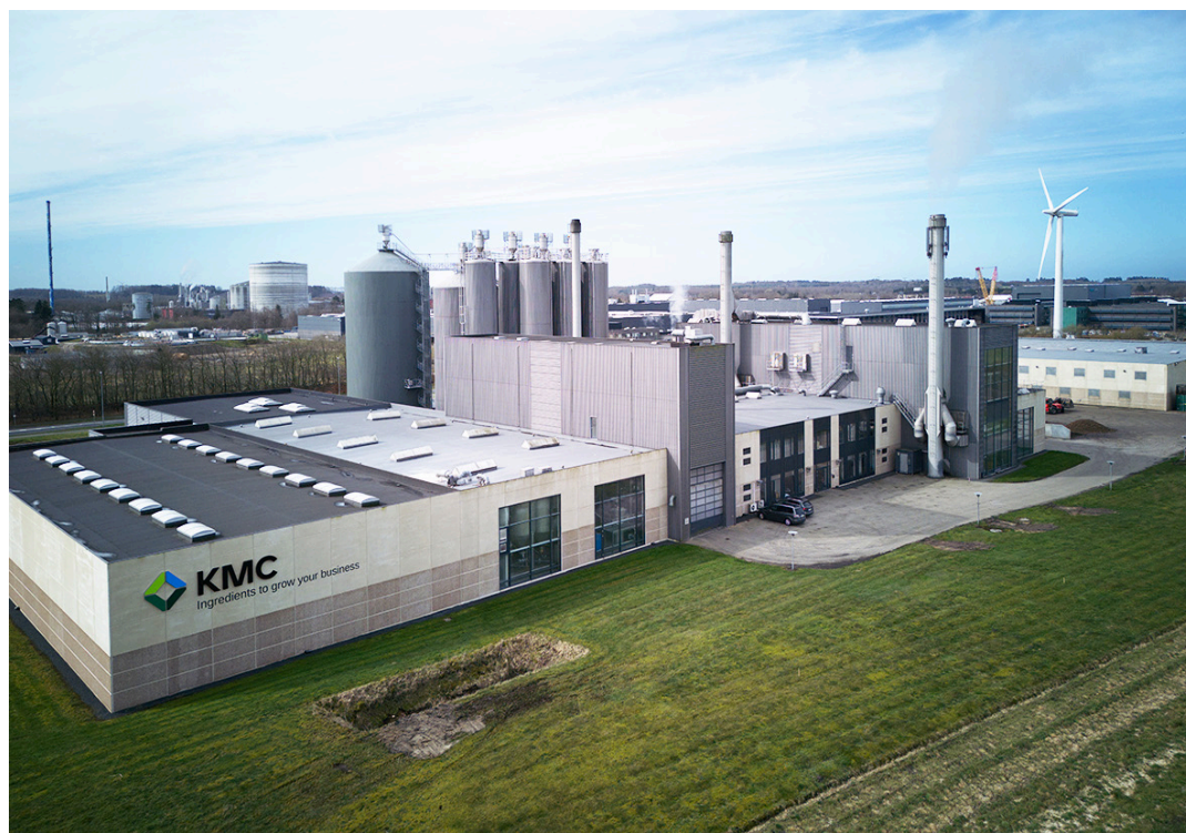
KMCs fabriksanlæg i Brande bliver både udvidet til granulatproduktion og til ingrediensproduktion. Pressefoto.
